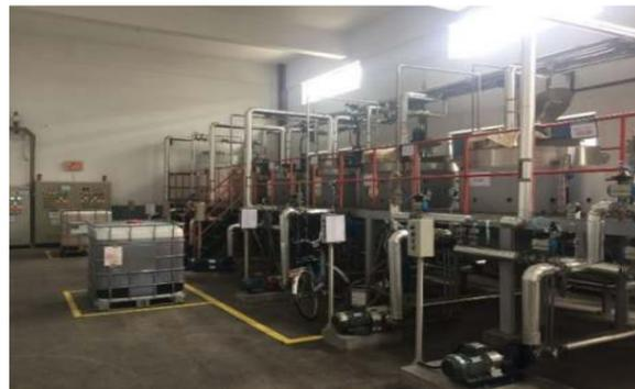
原料配送采用密闭管道系统输送，杜绝挥发性有机废气及粉尘的无组织飘逸扩散。
