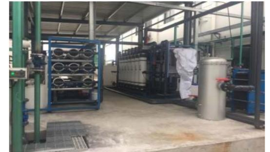
改善后：废水经处理后进入深度处理系统，回用于冷却水循环系统等。
